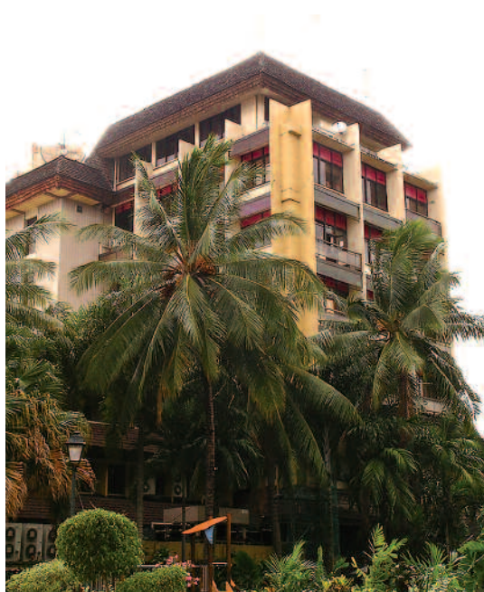
L'Hôtel des Postes du côté du parc Bougainville
