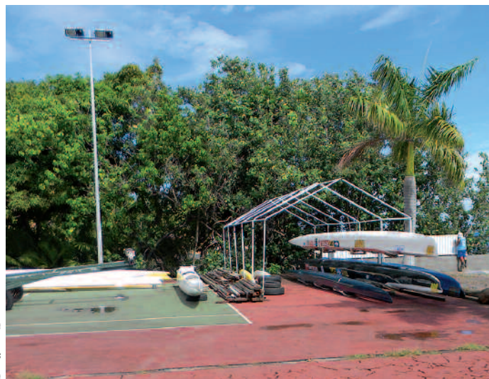
La première phase de rénovation du complexe sportif est achevée
