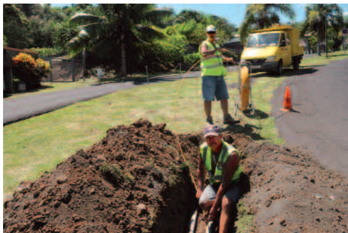
Projet initié en 2009 : un réseau en fibres optiques sur un site pilote près de Papeete
