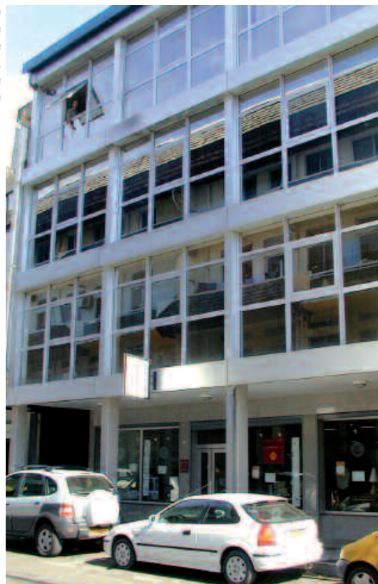
L'immeuble Shangrila, près de la gare maritime de Papeete, accueillera le service comptable
