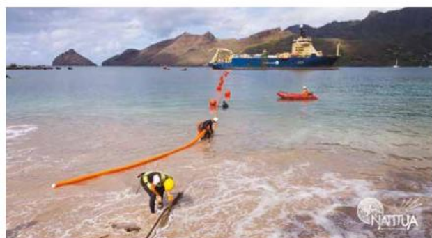
Installation du câble sous-marin Natitua à Nuku Hiva, aux Marquises
